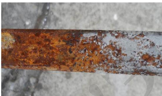
Рис.4. Пораженный ржавчиной фрагмент конструкции
