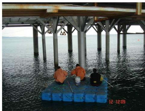
Рис.1. Очистка от ржавчины и нанесение антикоррозионного покрытия на опоры ПЛОТФОРМЫ
