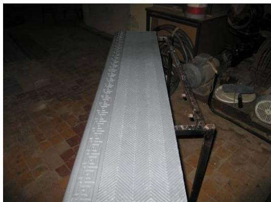
Рис.1. Очистка ступенек чугунной лестницы (до и после реставрации)
