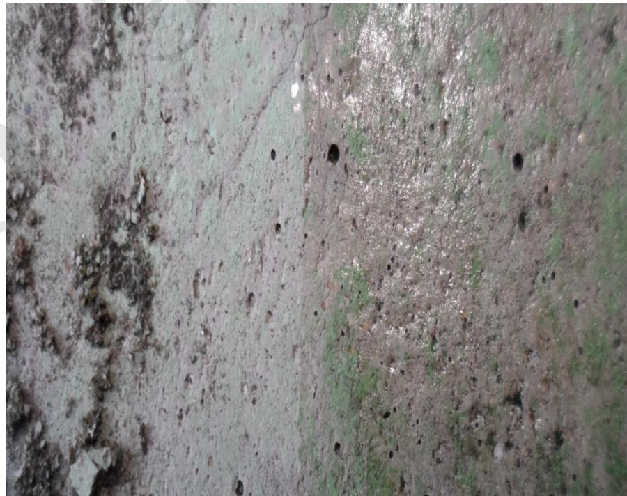
Фото. 5. Нанесение гидрофобизатора ЭкоСАН-ГФ с последующей сушкой поверхности
