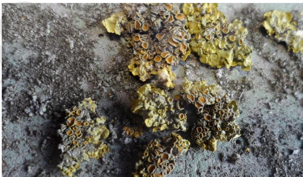
Фото. 2. Плантация грибковой плесени на внешней поверхности элеватора
