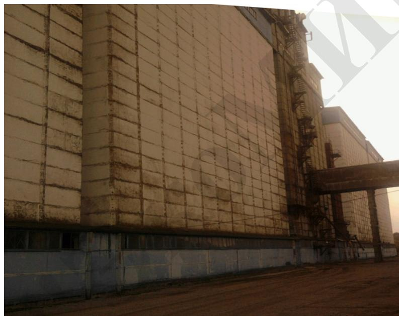
Фото. 1. Внешняя поверхность элеватора, пораженная грибковой плесенью
